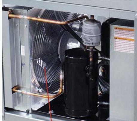
Typical condenser fan motor
